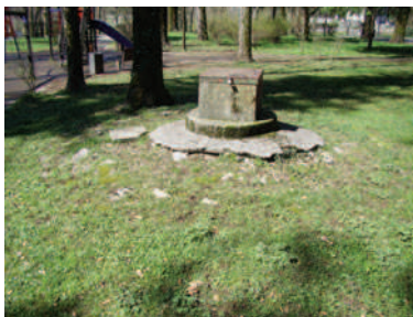
Slika 28. Bunar 2, prije izvođenja radova
